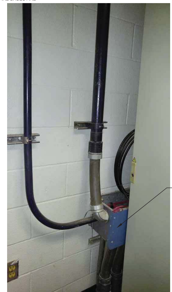
C EXISTING CMS CABINET-CABLE ROUTING SCALE: N.T.S.
